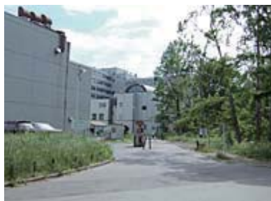
10 工学部北口玄関前
